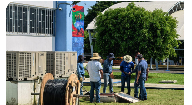
Instalación de fibra óptica
