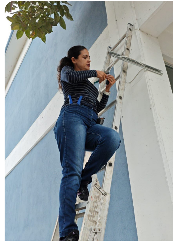
Trabajos de ampliación de conectividad institucional
