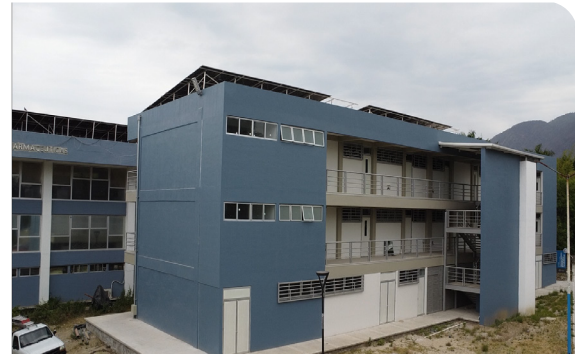
Edificio para laboratorios en la Unidad Académica de Ciencias Químicas Biológicas y Farmacéuticas
