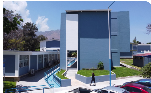
Habilitación de espacios en la Unidad Académica de Enfermería
