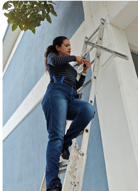
Trabajos de ampliación de conectividad institucional
