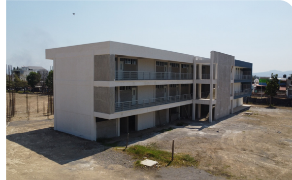
Edificio para la Unidad Académica de Artes (Albañilería, Acabados e Instalaciones)
