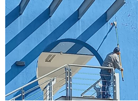
Mantenimiento de edificios
