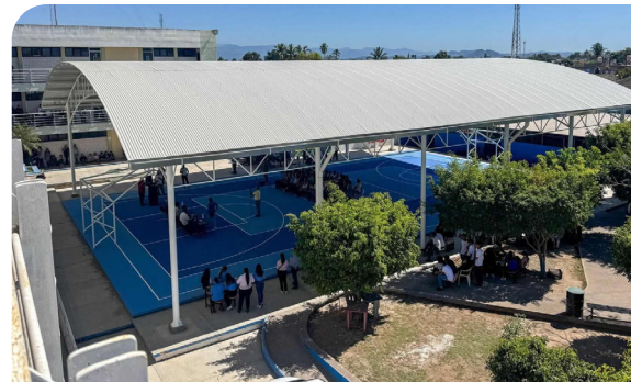
Construcción de cancha y domo en la Unidad Académica Preparatoria No 4
