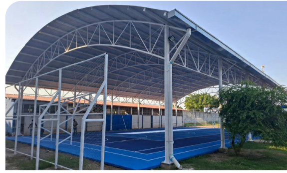
Construcción de cancha y domo en la Unidad Académica Preparatoria No. 2
