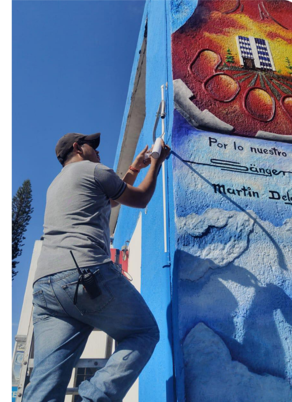
Instalación de cámaras de seguridad en el campus
