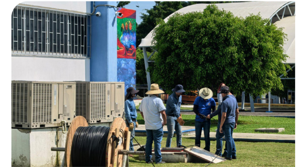
Instalación de fibra óptica
